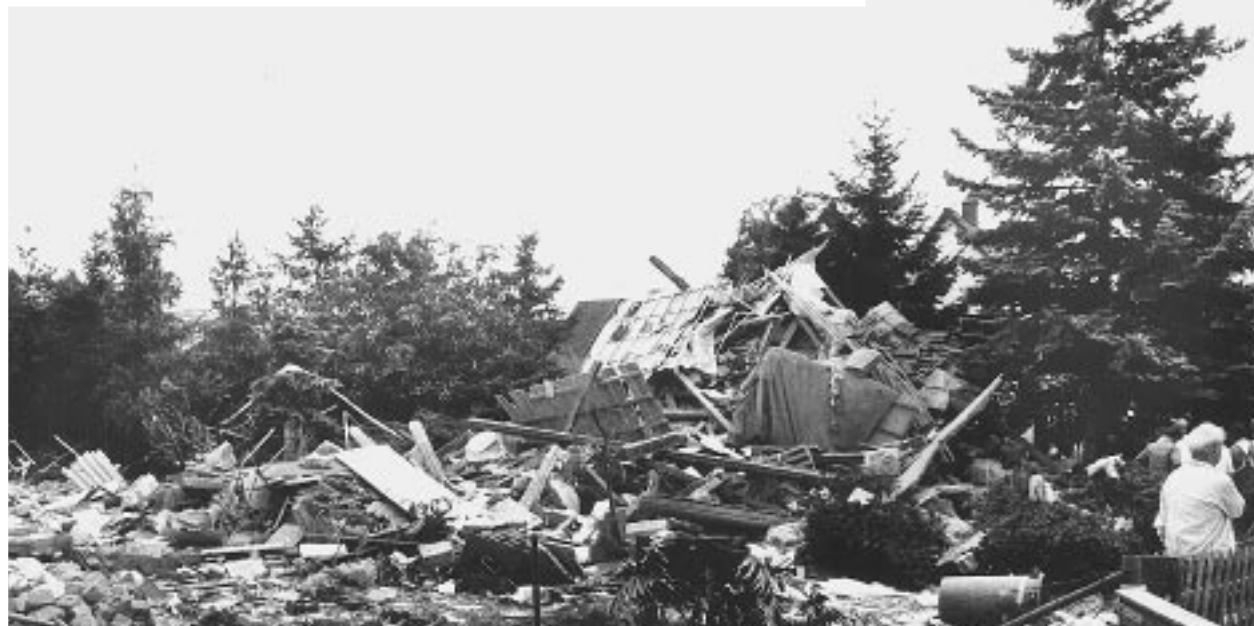
Nur noch ein Trümmerhaufen blieb von Leidigs Wohnung in der Heimstätteniedlung, aber die Bäume stehen (Foto Heiner Schäfer)
